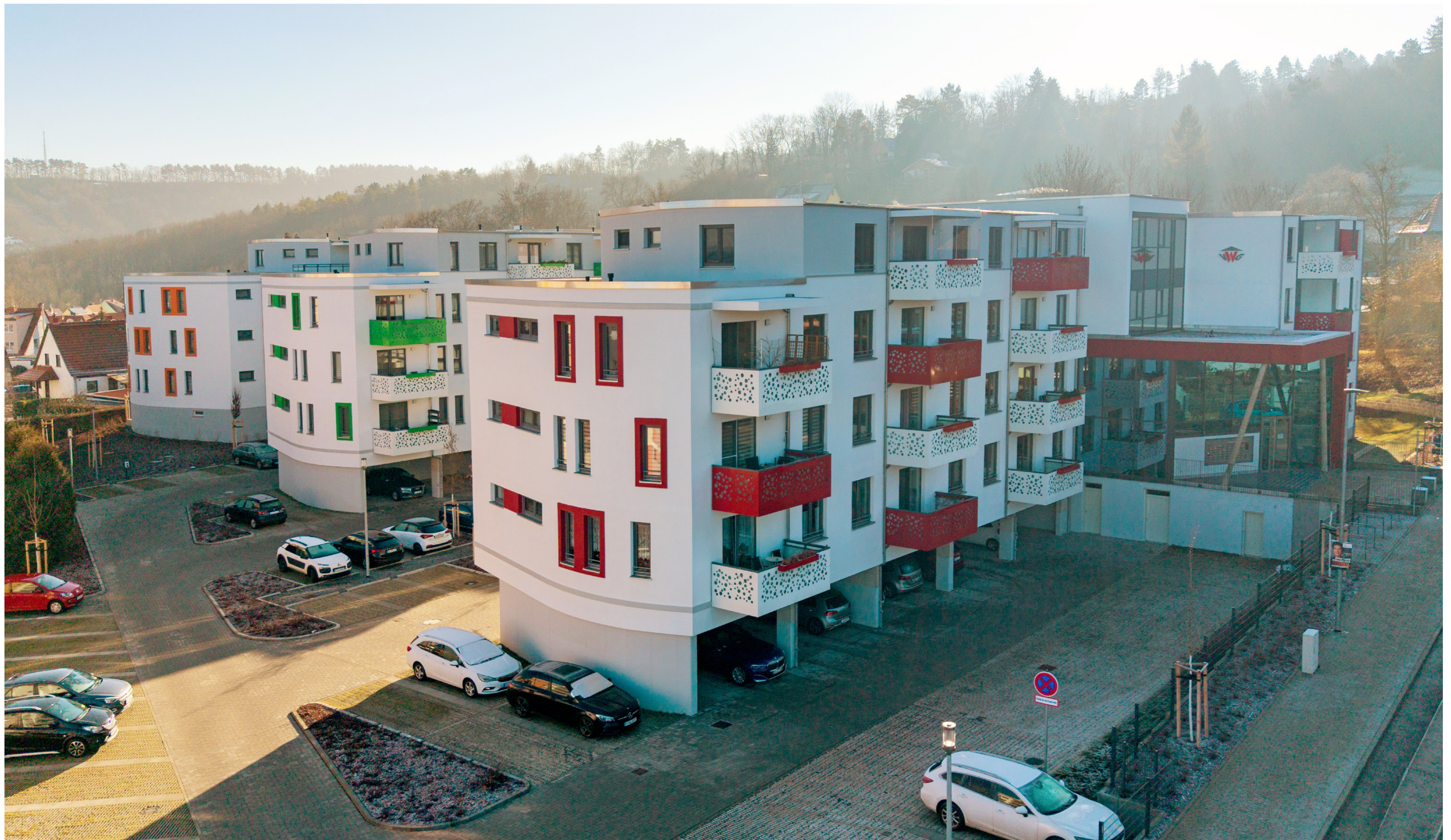
Außenansicht Schillerstraße, Fotos: Johannes Krey, jkftv.de
