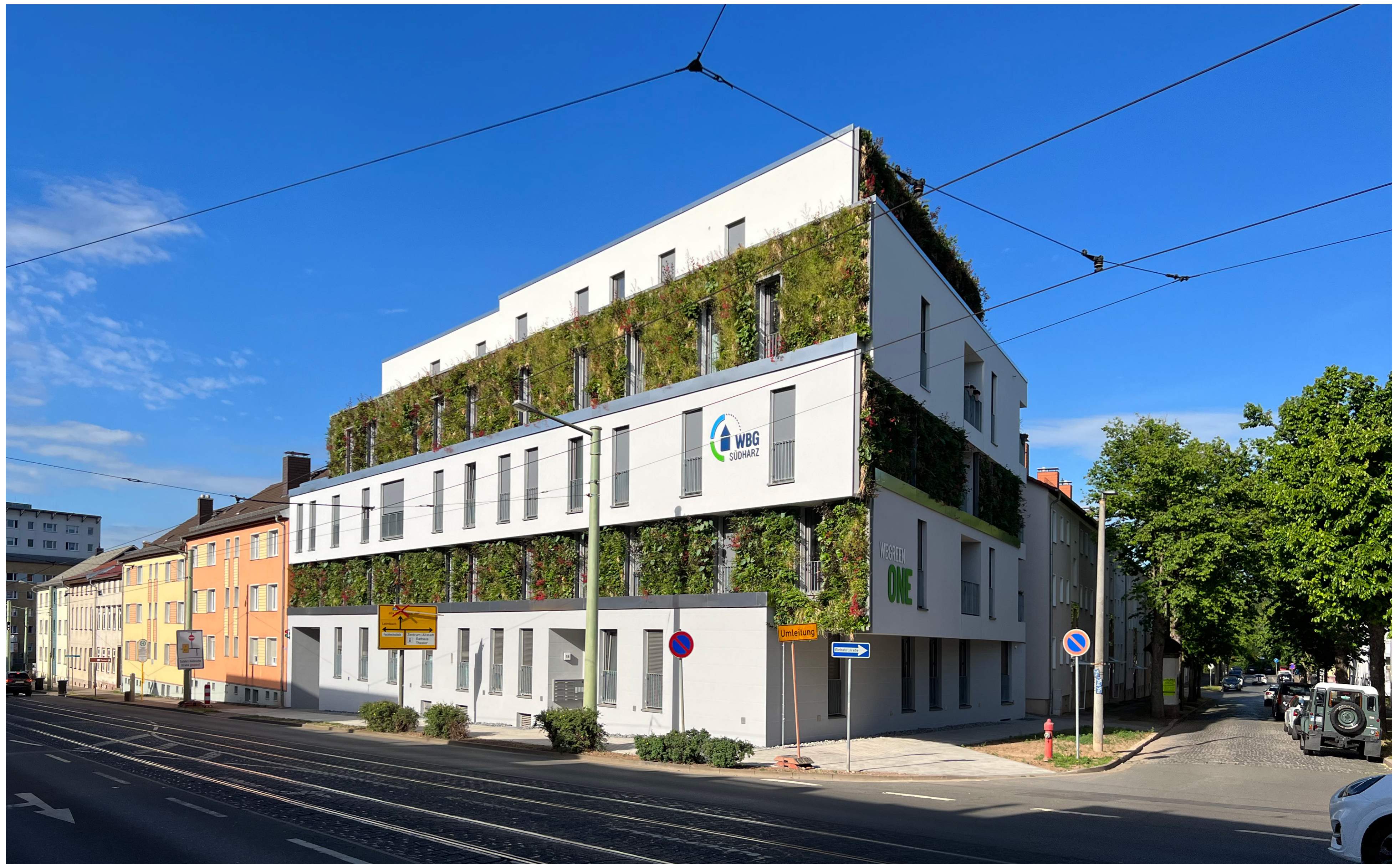
Straßenansicht Ost mit Loggien
